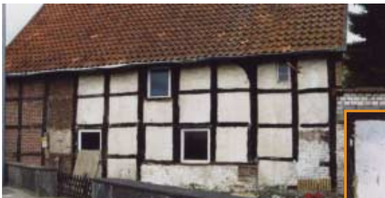
Das alte Fachwerkhaus war ungedämmt und nur mit Nachtspeicheröfen ausgestattet.
